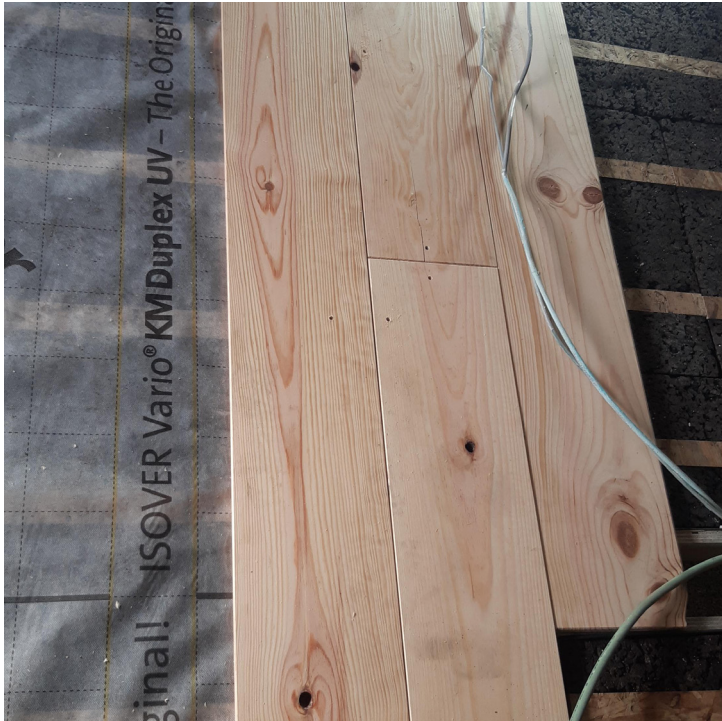
PLANKENVLOER: recuperatie (20 mm) KURK LAMBOURDES: geëxpandeerde kurkblokken voorzien van 2 stroken OSB (50 mm) KURK ISOLATIEPLAAT: geëxpandeerde kurkblokken (20/60 mm) EGALISATIEKORRELS: opgeblazen kalksteen (30 mm) bestaande dekvloer bestaande draagvloer
