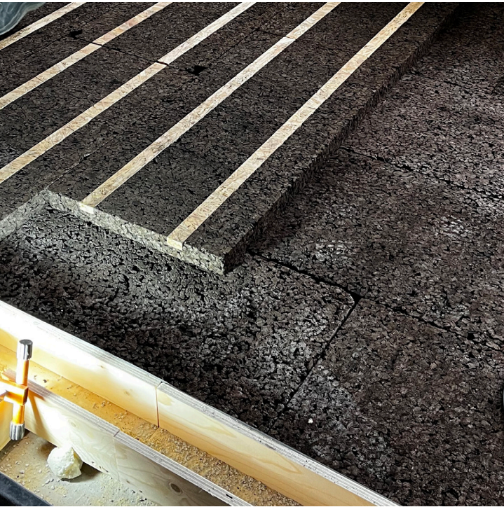
PLANKENVLOER: recuperatie (20 mm) KURK LAMBOURDES: geëxpandeerde kurkblokken voorzien van 2 stroken OSB (50 mm) KURK ISOLATIEPLAAT: geëxpandeerde kurkblokken (20/60 mm) EGALISATIEKORRELS: opgeblazen kalksteen (30 mm) bestaande dekvloer bestaande draagvloer
